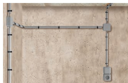
Гибкие и жесткие трубопроводы
