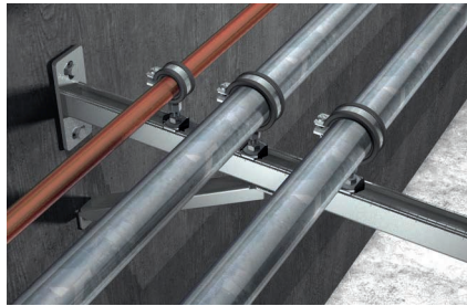
Крепление трубопровода к стене
