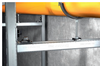
Крепление трубопровода на рамной конструкции
