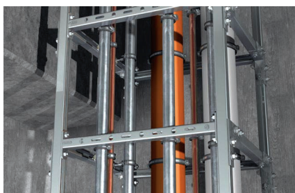
3х-мерная рамная конструкция
