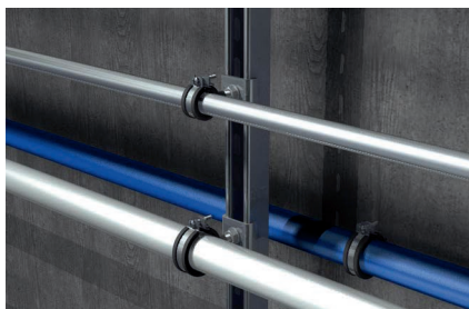
Монтаж поперечных труб к шинам
