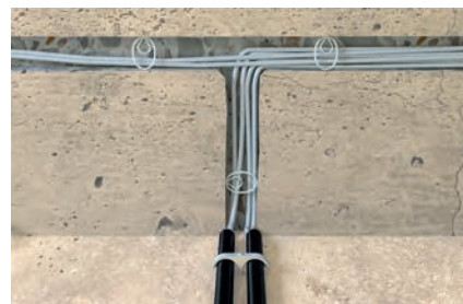
Крепление кабелей в штробах стен шириной < 55 мм
