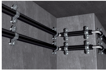
Крепление стальных трубопроводов в защитной оболочке
