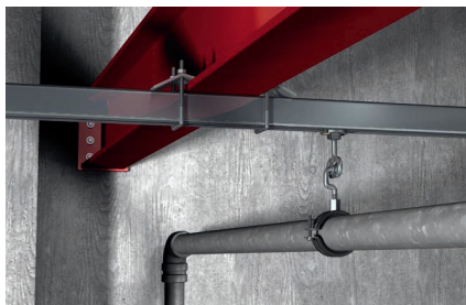
Крепление шин к стальным балкам
