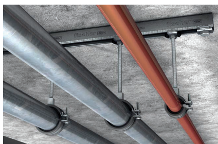
Крепление трубопровода с помощью монтажных шин
