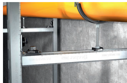
Крепление трубопровода на рамную конструкцию
