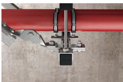
Усиление конструкции из монтажных шин
