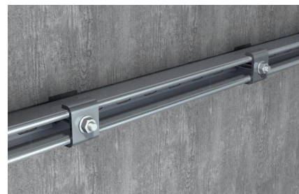
Монтаж шин к стене
