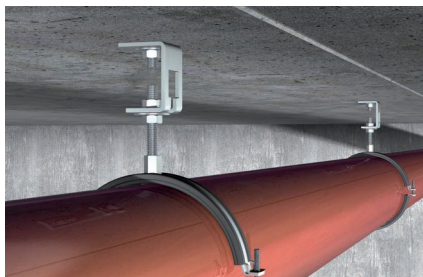
Монтаж трубопровода с регулировкой по высоте
