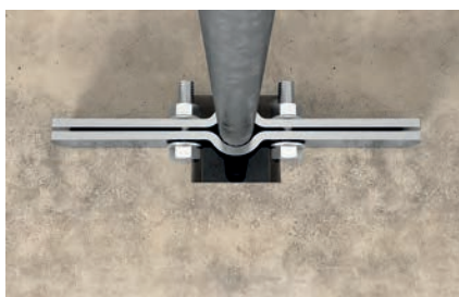
Крепление трубопровода, проходящего через перекрытие
