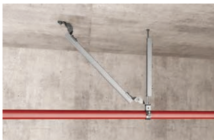
Усиление узла крепления трубопровода с помощью монтажной шины
