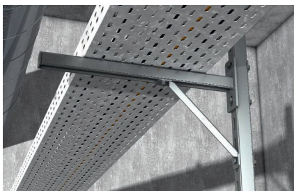
Крепление кабельного канала на консольную конструкцию
