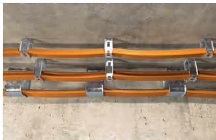
Крепление кабелей к перекрытию
