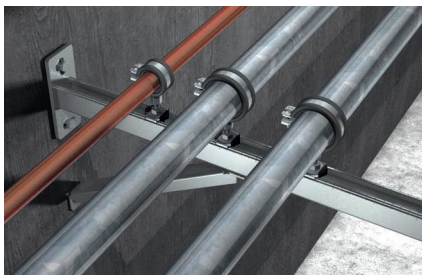
Крепление трубопровода к стене
