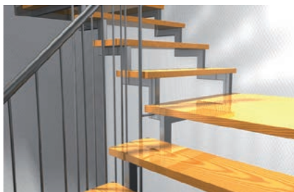
Лестничные ступени на стальных лестничных балках
