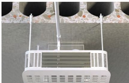
Крепление кондиционеров в предварительно напряженных пустотелых бетонных плитах
