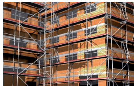
Фасадные строительные леса
