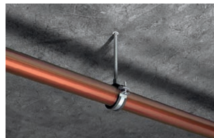
Монтаж одиночных труб
