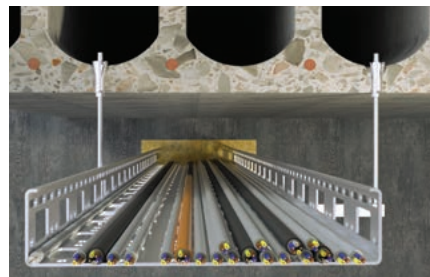
Крепление кабельных лотков в предварительно напряженных пустотелых бетонных плитах
