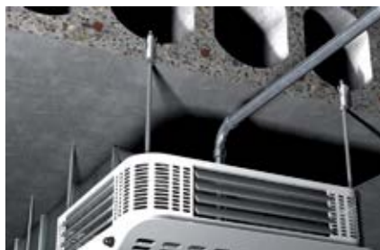
Крепление кондиционеров в предварительно напряженных пустотелых бетонных плитах
