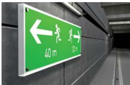
Знаки аварийного выхода в туннелях
