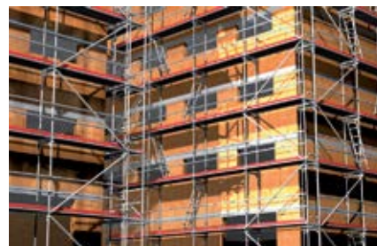
Фасадные строительные леса
