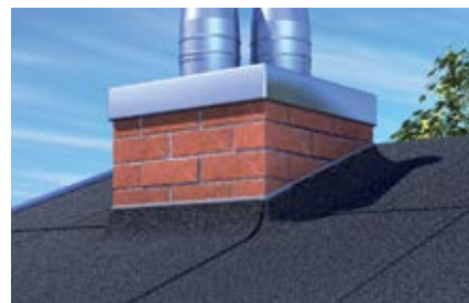
Герметизация кровли с применением листового битума
