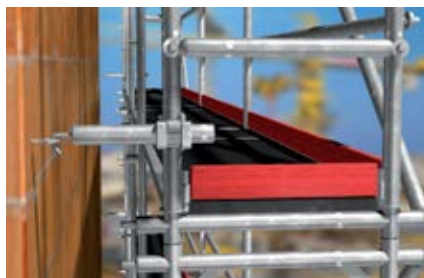
Крепление строительных лесов
