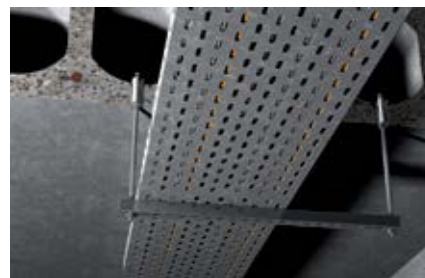
Крепление кабельных лотков в предварительно напряженных пустотелых бетонных плитах
