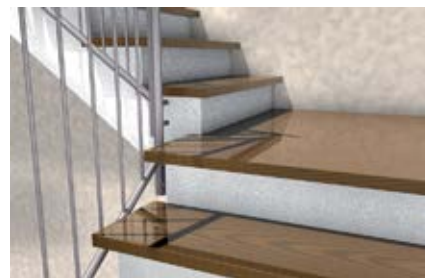
Лестничные ступени на бетонных лестничных балках
