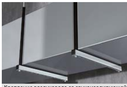
Крепление воздуховода со звукоизолирующей вставкой на монтажной шине
