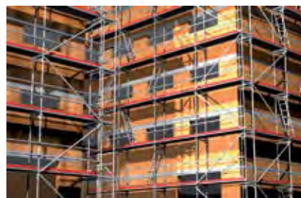
Фасадные строительные леса
